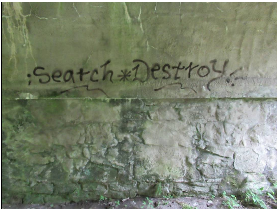
Obr. č. 7 - pohled na patu klenby a spodní stavbu z kamenného zdiva
