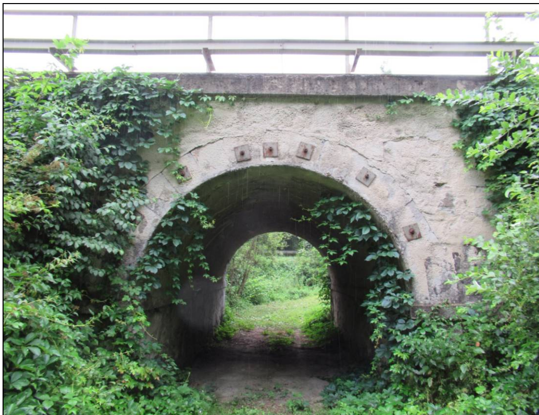
Obr. č. 3 – pohled na objekt zleva (v čele klenby zhlaví ocelových táhel)
