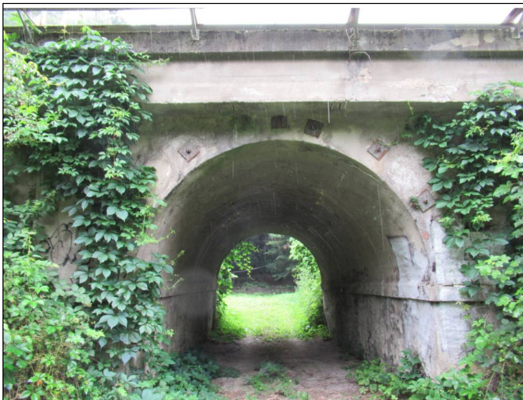
Obr. č. 4 - pohled na objekt zprava (v čele klenby zhlaví ocelových táhel)
